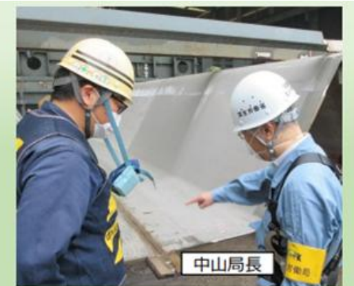
作業概況の点検を行う様子
