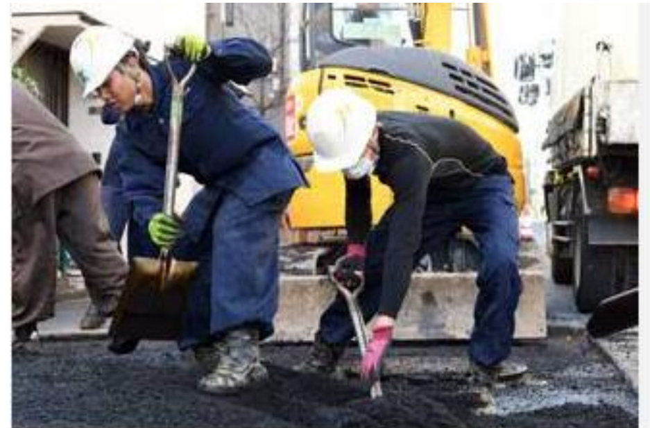
道路の舗装作業に従事するベトナム人技能実習生ら。熱心に働く実習生がいる半面、やる気のうかがえない実習生もいるという
